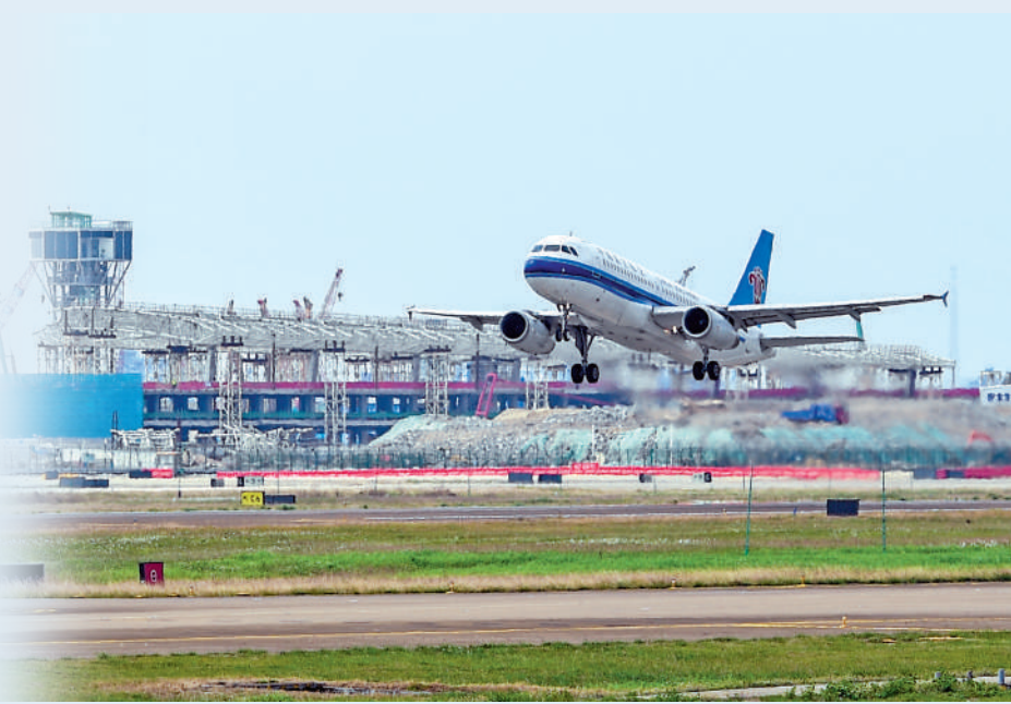
▲深圳機場三跑道擴建工程正在推進行，滿足8000萬年旅客吞吐量、260萬噸貨郵吞吐量目標。圖為南方航空公司一架客機從深圳機場起飛。新華社
