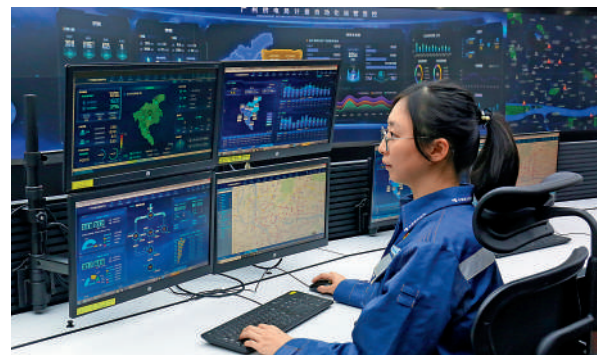
▲南方電網工作人員操作計量自動化系統平台實時監測用電。
