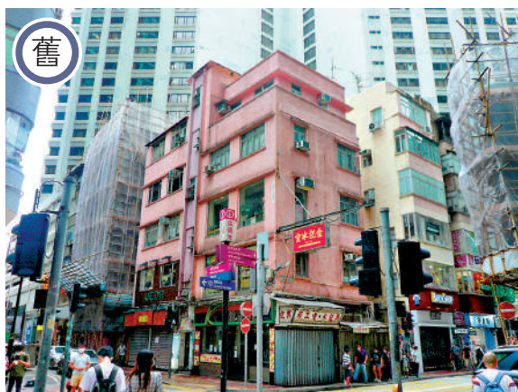
►雲東街和勿地臣街交界處可覽唐樓群整體新貌。
