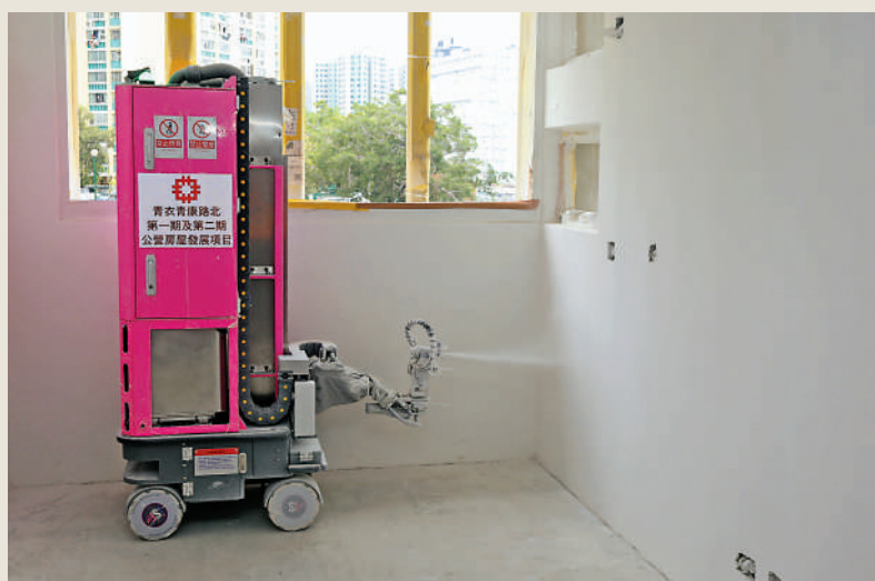
▲房屋署高級結構工程師姚勳雄表示，「室內油漆噴塗機器人」整體表現初步令人滿意，質量穩定。大公報記者黃洋攝
