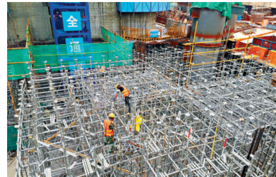
▲「空中造樓機」外側的工地上，工人們正在施工。大公報記者石華攝
