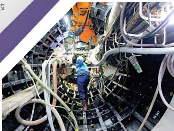
▶東電公布海底隧道照片。網絡圖片
