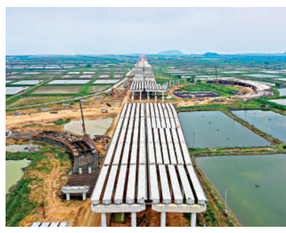
▲黃茅海跨海通道江門台山段赤溪東互通架樑現場。新華社
