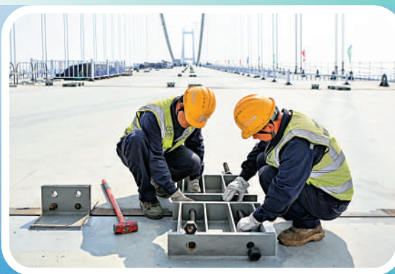
▲4月28日，工作人員安裝伶仃洋大橋最後一片鋼箱樑的匹配螺桿件。中新社
