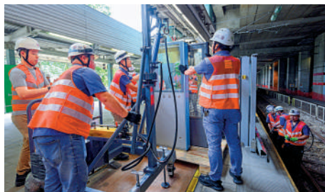
▲港鐵展開東鐵綫自動閘門安裝工程，馬場站已安裝完成，並率先投入服務。
