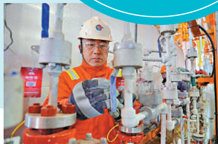
▲項目工程師調試接收站內部管線，為項目後續平穩運行進行測試。
