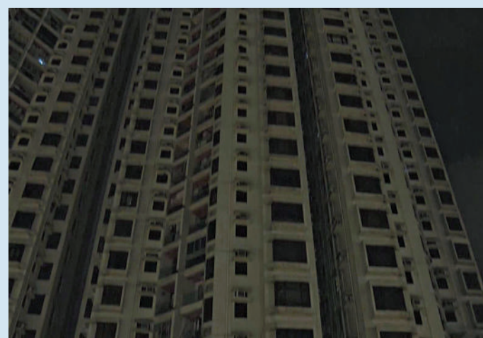
▲港島上月19日凌晨發生供電事故，多區受到影響，其中位於港島東的杏花邨更是漆黑一片。
