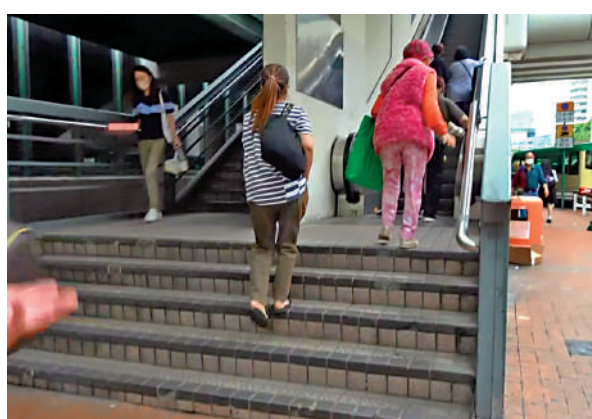
▲葵芳港鐵站D出口外的扶手電梯，因興建了地台收藏電梯機組，雖然節省成本，但對長者或推嬰兒車的人士非常不便。
