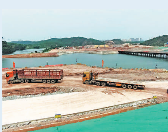
▲廣西欽州，西部陸海新通道（平陸）運河青年樞紐現場。中新社
