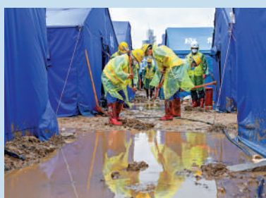
▲2022年3月23日，在中央援港應急醫院施工現場，工人在清理積水和淤泥。新華社
