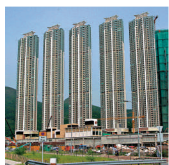
▲日出康城「首都」有裝修單位懷疑拆除了主力牆，引起居民關注。
