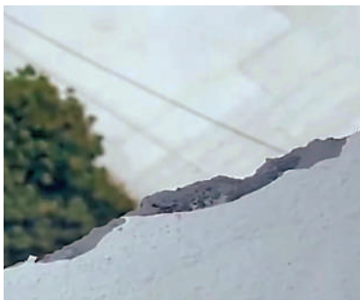
◀▲昨日早上屯門和田邨一個高層單位遭雷電擊中，發出巨響及有火光，戶主事後發現外牆有損毀。
