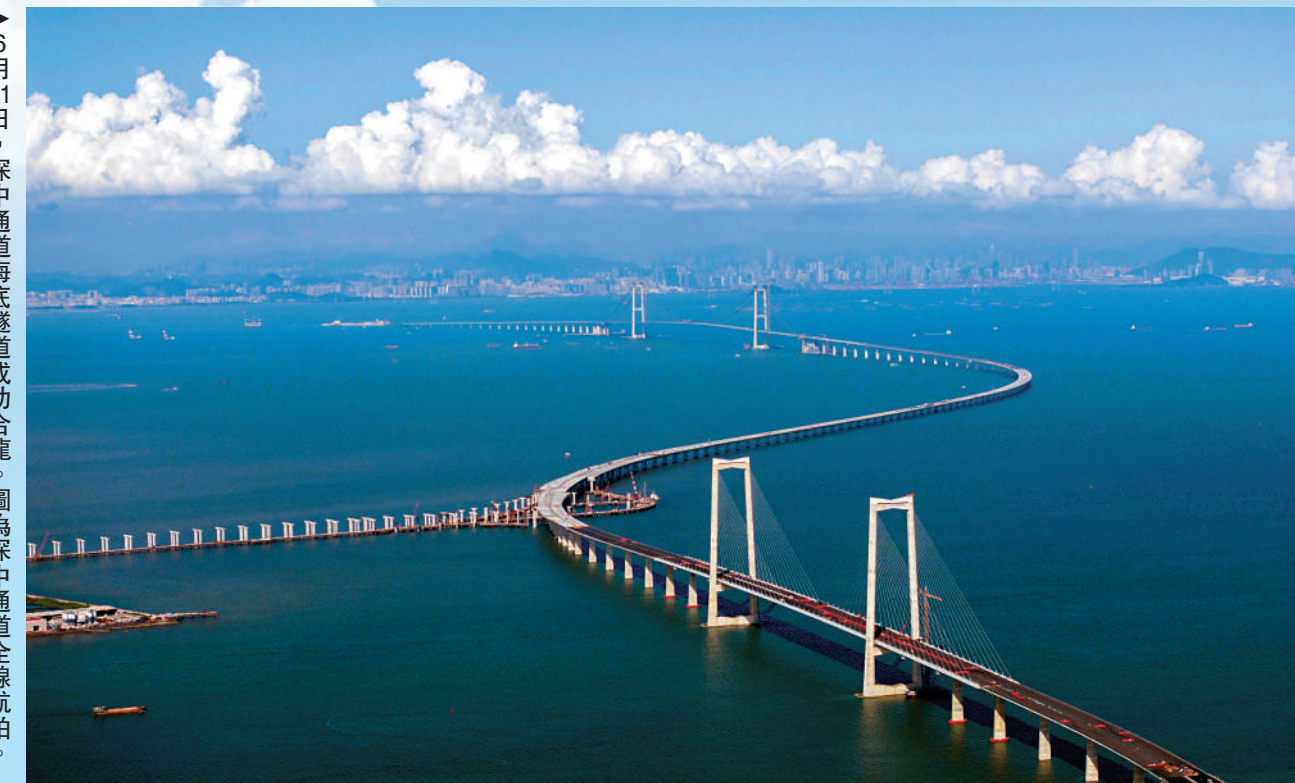
6月11日，深中通道海底隧道成功合龍。圖為深中通道全線航拍。
