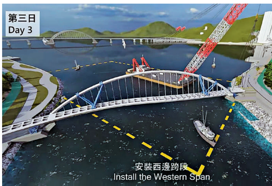
▲工程第三日會安裝接駁岸邊的組件，接通整條南橋。電腦模擬圖
