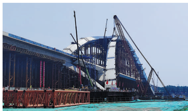
▲京雄大橋施工現場。
