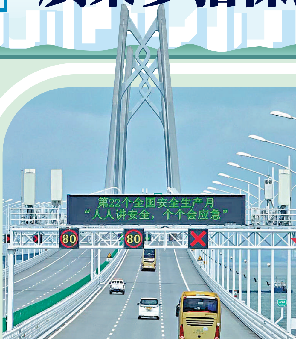
▲港珠澳大橋發布通行安全指引。圖為大橋可變信息與車道控制標誌。
