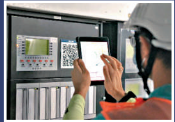
▲港鐵實施工地數碼化，提升工程安全、質素及效率。
