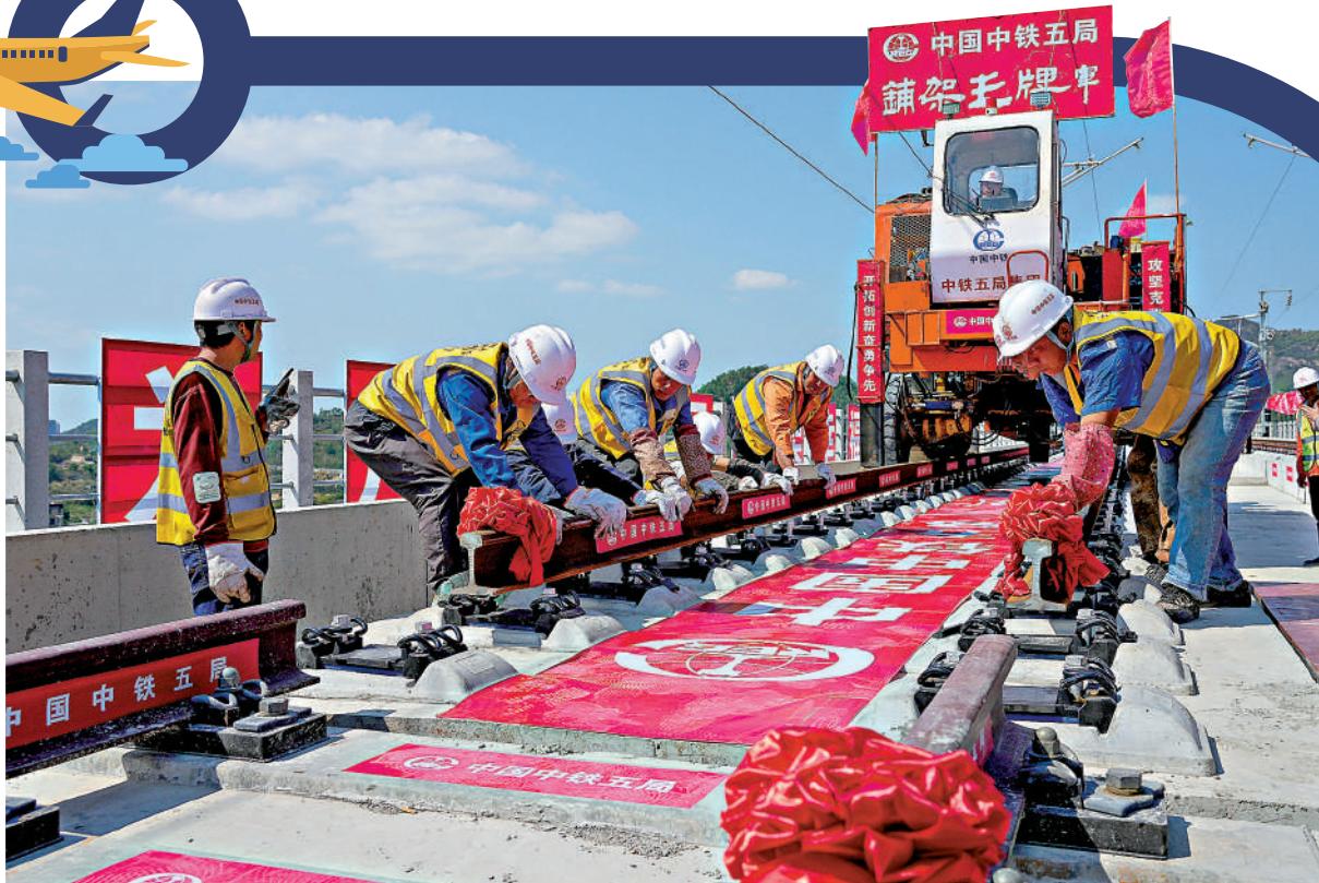
2月23日，廣汕鐵路正線鋪設軌道正線最後一組500米長軌。
