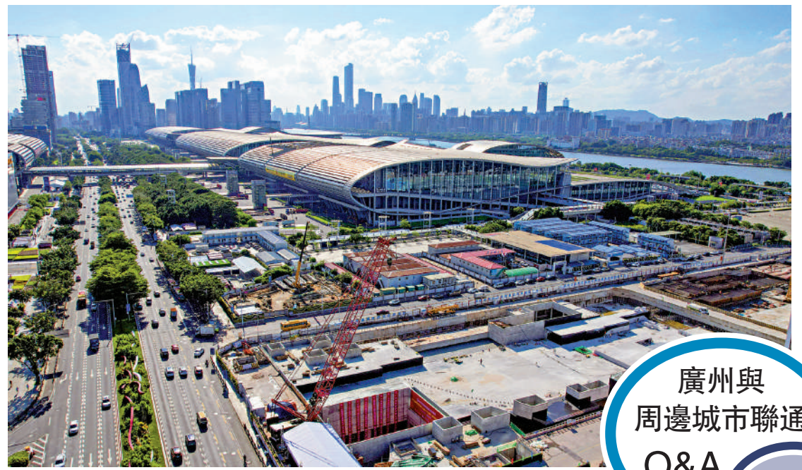
▲廣州加快推進鐵路建設。圖為廣州珠三角城際支線施工現場。中新社
