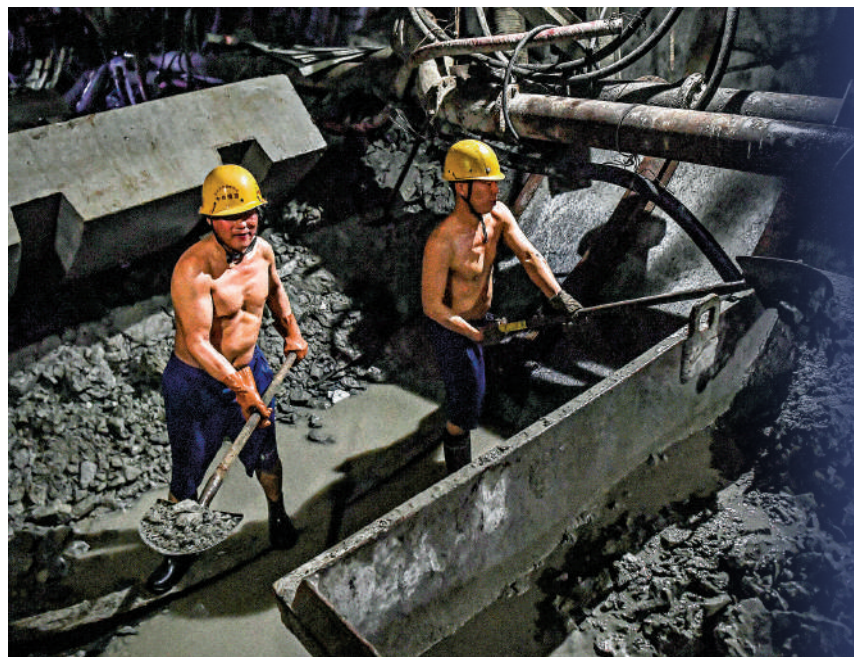
▲2020年11月18日，工人在秦嶺輸水隧洞掘進機底部清理渣石。 新華社
