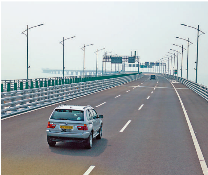
▲港珠澳大橋橫跨三地水域，車主及司機在使用大橋前，須因應路線和目的地，購備所需保障範圍的保單。
