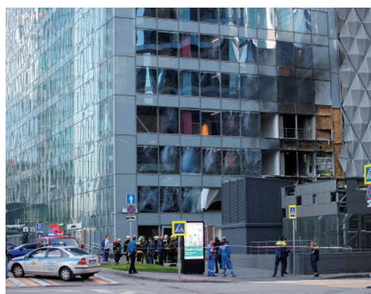
▲烏克蘭無人機襲擊導致莫斯科市區辦公樓受損。路透社
