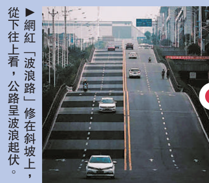
▶網紅「波浪路」修在斜坡上，從下往上看，公路呈波浪起伏。
