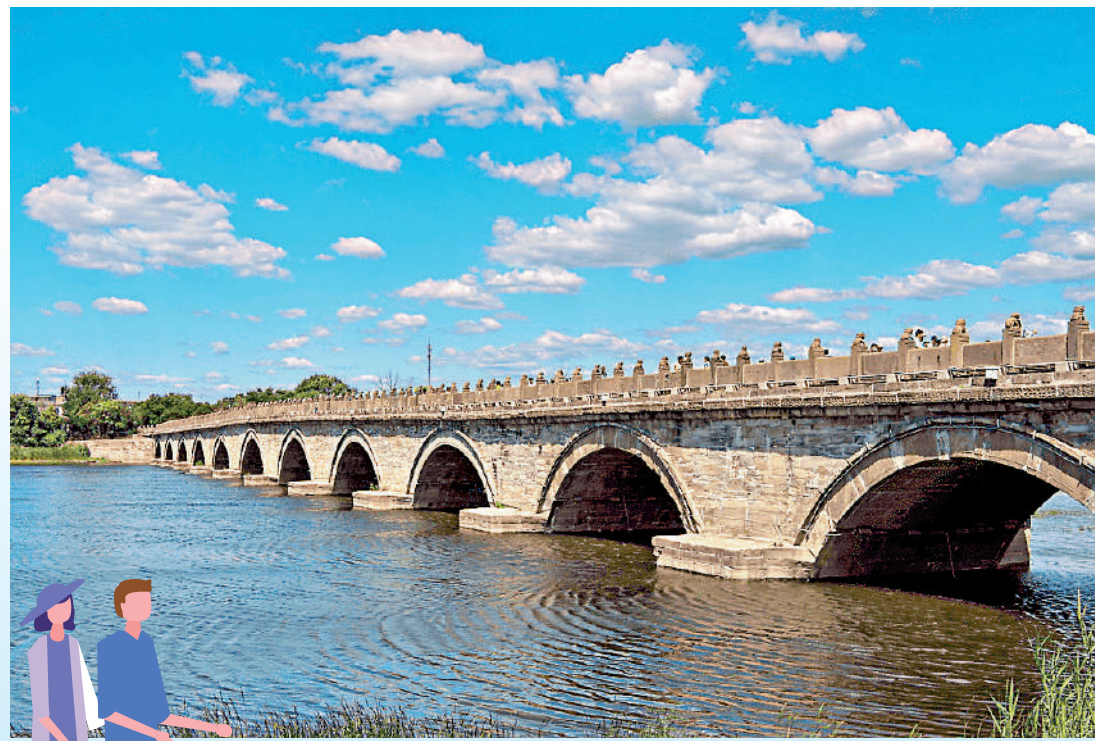
▲永定河夏日水位平時不會完全漫過盧溝橋橋墩。圖中可見盧溝橋橋墩背面呈方形，與迎水面設計不同。
