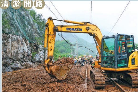
▲8月1日，北京門頭溝區，豐沙鐵路妙峰山鎮水峪嘴村段，大型機械在清淤。
