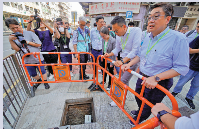
▲政府人員視察荃灣芙蓉街渠管污染修復進度，該沙井內已安裝攝錄鏡頭，持續監察污水流動情況。大公報記者林少權攝
