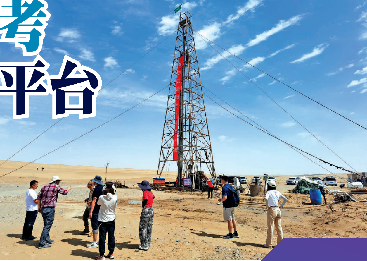
▲塔克拉瑪干沙漠腹地岩芯鑽探現場。
