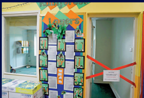
▲英格蘭地區一所小學部分建築因存在安全隱患被停用。美聯社
