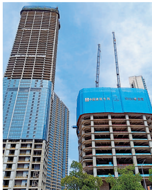
▲南京市中心的在建樓盤。 大公報記者賀鵬飛攝
