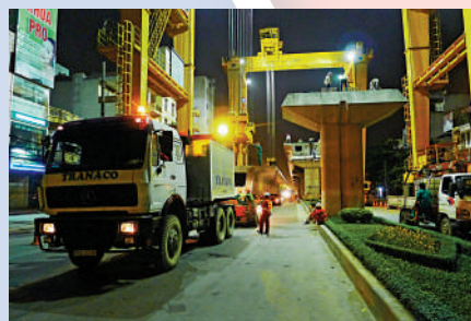
▲建設中的越南河內城市軌道交通吉靈—河東線項目。
