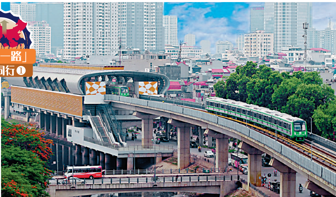
▲河內城市軌道交通吉靈—河東線項目是越南開通運營的首條輕軌。
