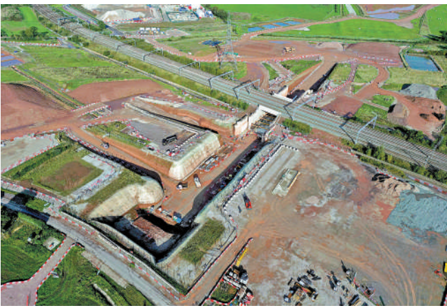
▲英國宣布停建HS2高鐵路部分路段引發外界抨擊。圖為一個高鐵路站點工地。法新社
