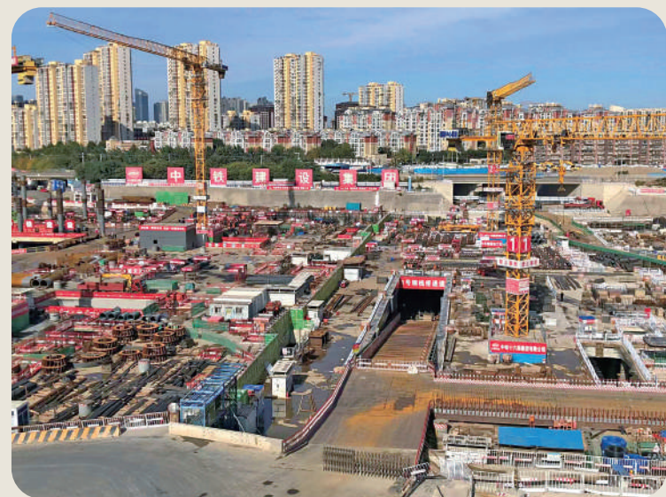
正在興建的北京副中心立體交通樞紐。 作者供圖
