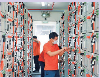
▲廣東某企業的集成儲能裝置內，職員正在進行安裝工作。
