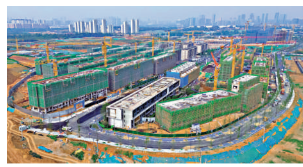
成都一新建住宅項目施工现场。
