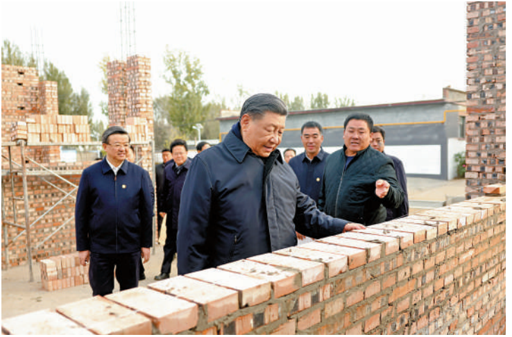
▲10日下午，習近平在河北保定涿州市刁窩鎮萬全莊村房屋重建施工現場考察。
