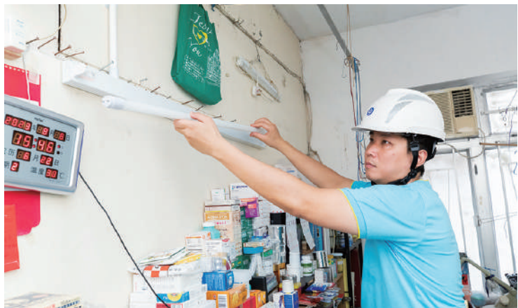
▲工程人員為林婆婆的單位更換光管、安裝門鐘及添置智能拖板等電力裝置。
