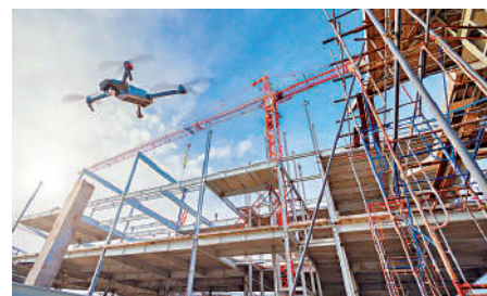
▲無人機以全景視角獲取工地信息，有效檢視防護網、周邊建築物等。
