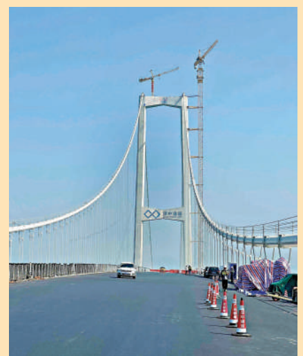
▲ 正在施工中的伶仃洋大橋橋塔。大公報記者帥誠攝
