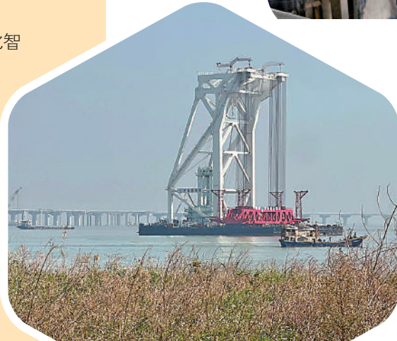
▲施工中的深中通道項目。 大公報記者帥誠攝
