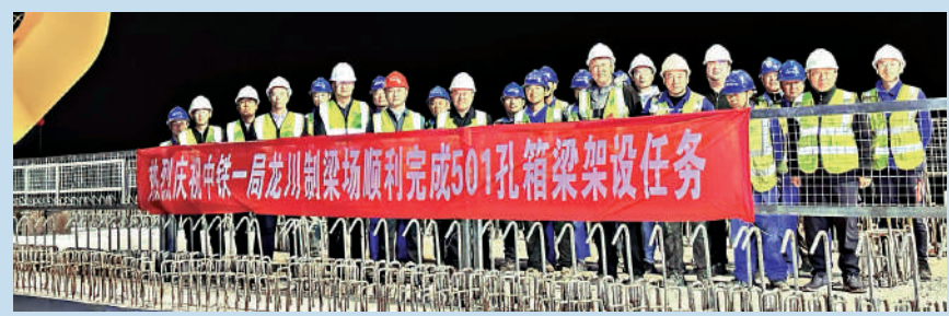
▲11月14日，梅龍高鐵路龍川段最後一片箱樑完成架設，標誌全線橋樑架樑工程全面完工。
