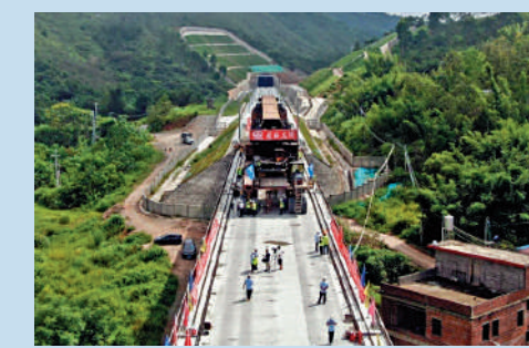
▲梅龍高鐵路施工現場。受訪者供圖
