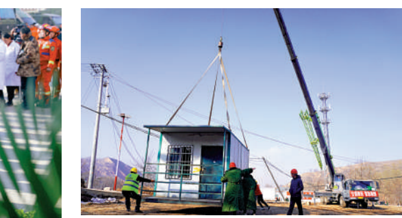
▲工作人員連日在甘肅臨夏州積石山縣劉集鄉陶家村活動板房建設現場施工。
