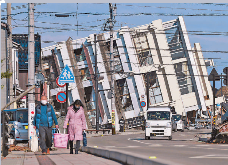
▲日本石川縣輪島市一棟建築物2日因地震倒塌。美聯社
