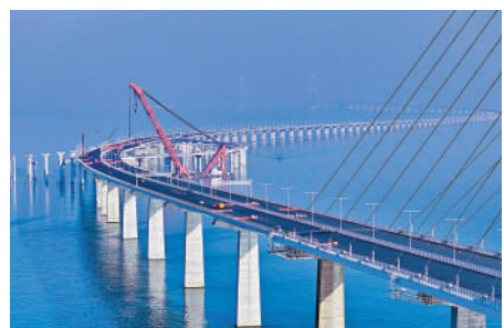
▲深中通道將促使兩地車程縮減為約20分鐘。圖為深中通道正在建設中。受訪者供圖
