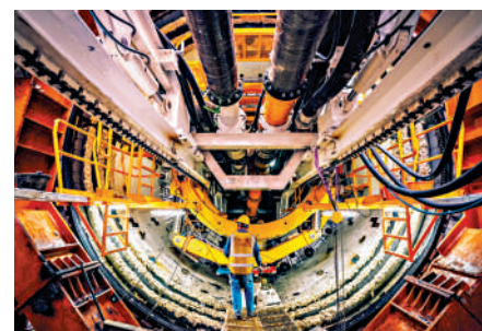
▲此前建設中，珠三角工程盾構掘進階段施工場景。
