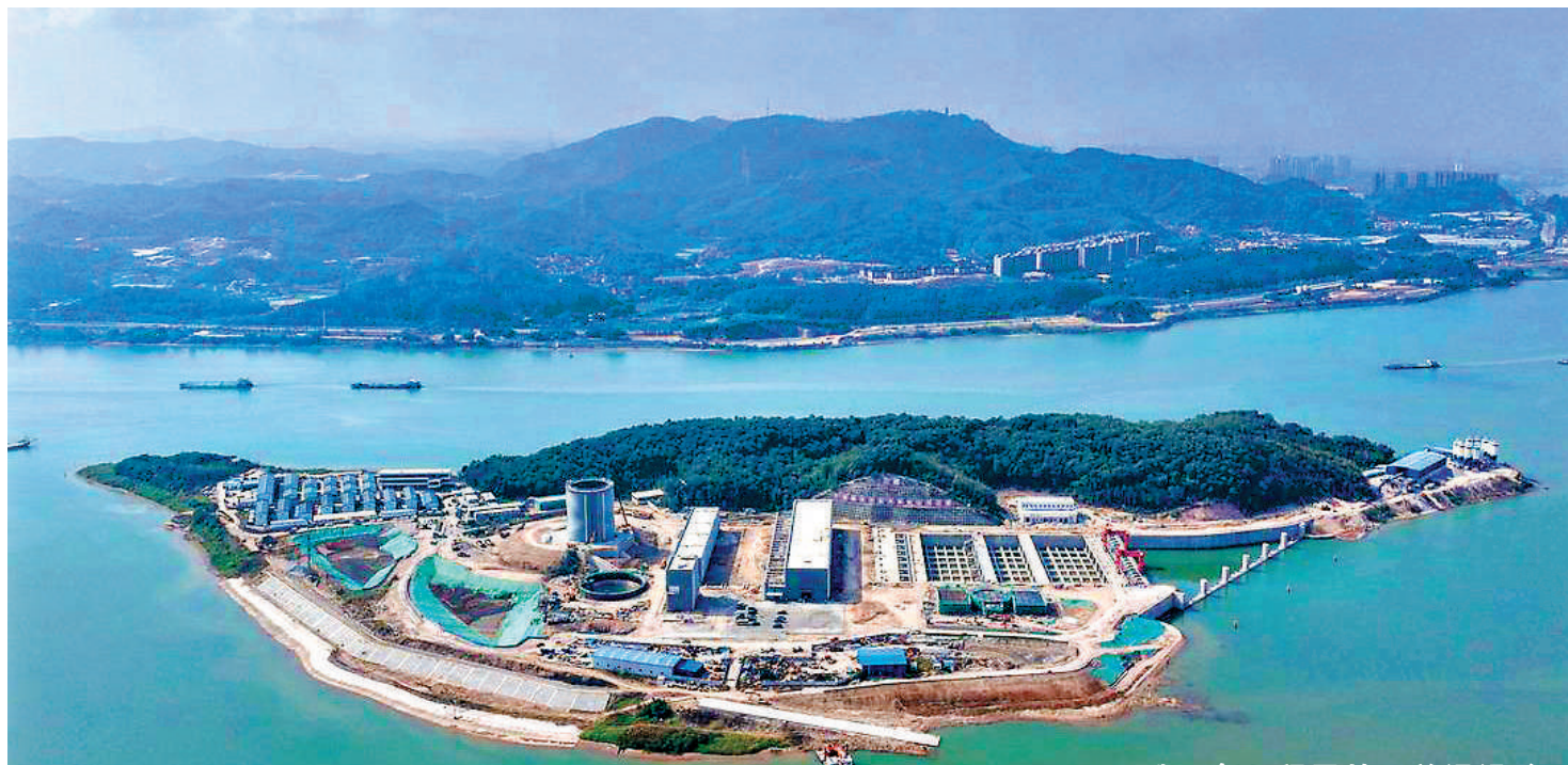
▲珠三角工程已於日前通過驗收，具備全線通水條件。圖為珠三角工程鯉魚洲泵站。
