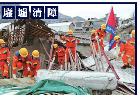
▲救援隊員在廢墟瓦礫中清除障礙物。
