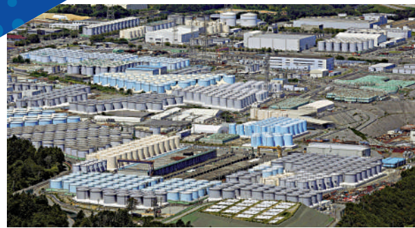
水7日發生洩漏。 資料圖片
