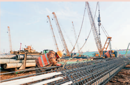
◀2月16日，河北省雄安新区的雄忻高鐵路安城際站施工現場。
